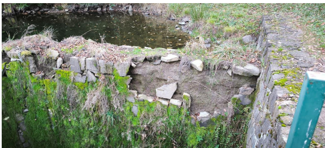
Pohled na levou přelivnou hranu u sdruženého objektu – z prostoru vývaru
